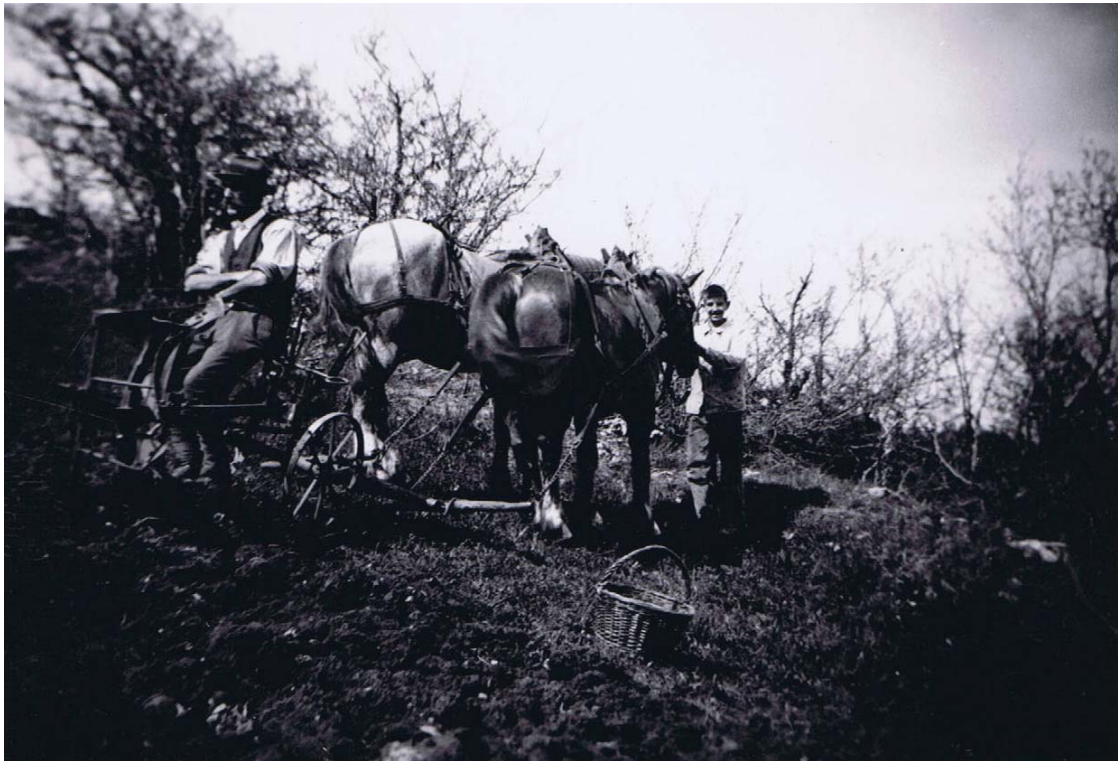
Labours en dessus du Chemin qui va aux Combes. Période 1939-1945. Avec Raymond Guignard au centre.
